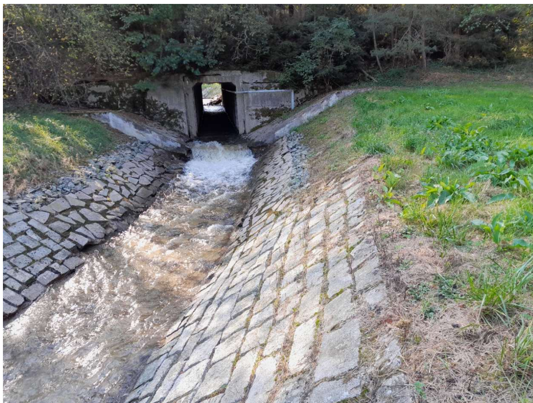
8. Pohled na opevnění na levém břehu
