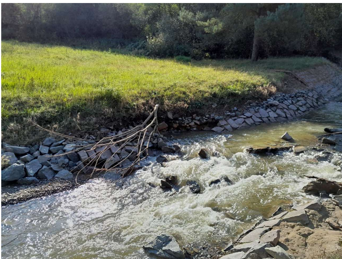
6. Pohled na rozplavené opevnění na pravém břehu
