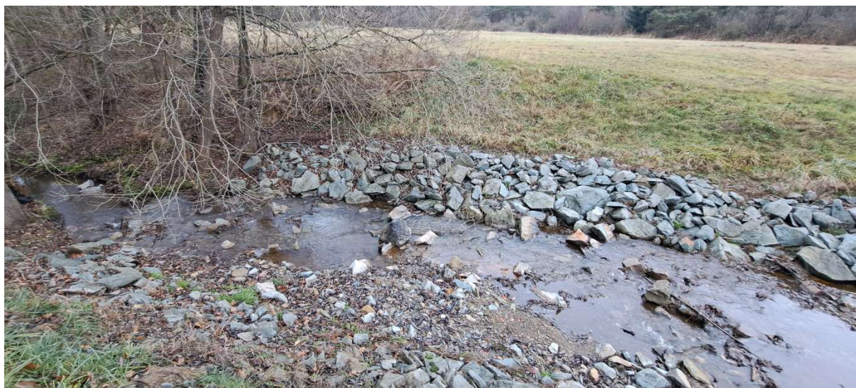
1. Začátek opevněného úseku – pohled na porušený pravý břeh a nánosy ve dně
