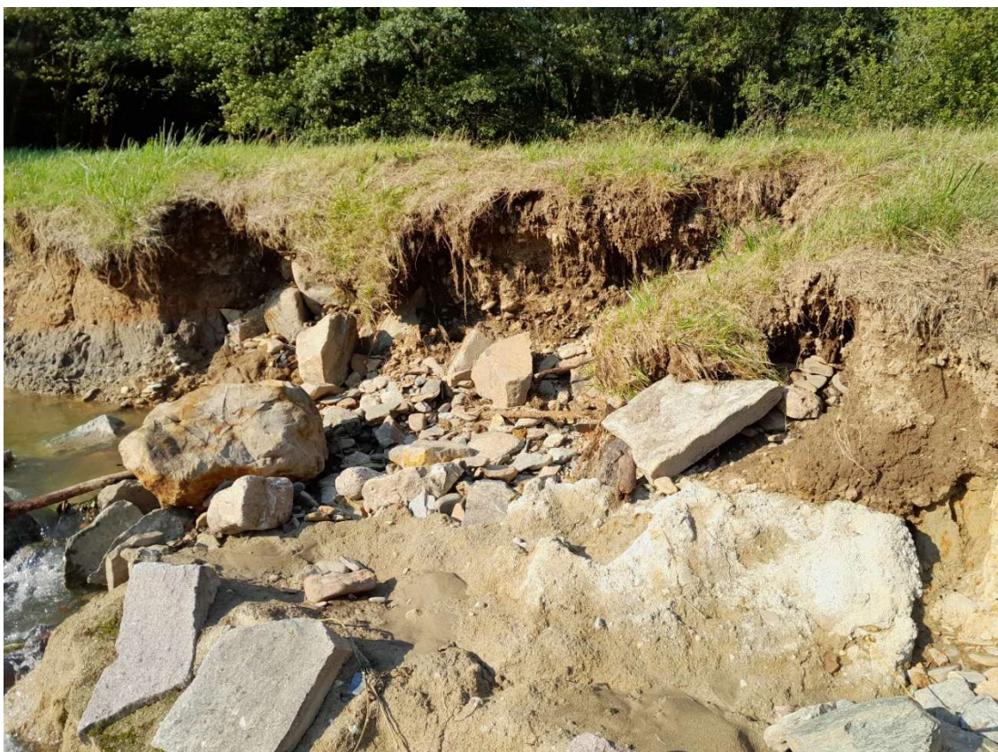
5. Pohled na nátrže na levém břehu a rozplavené původní opevnění
