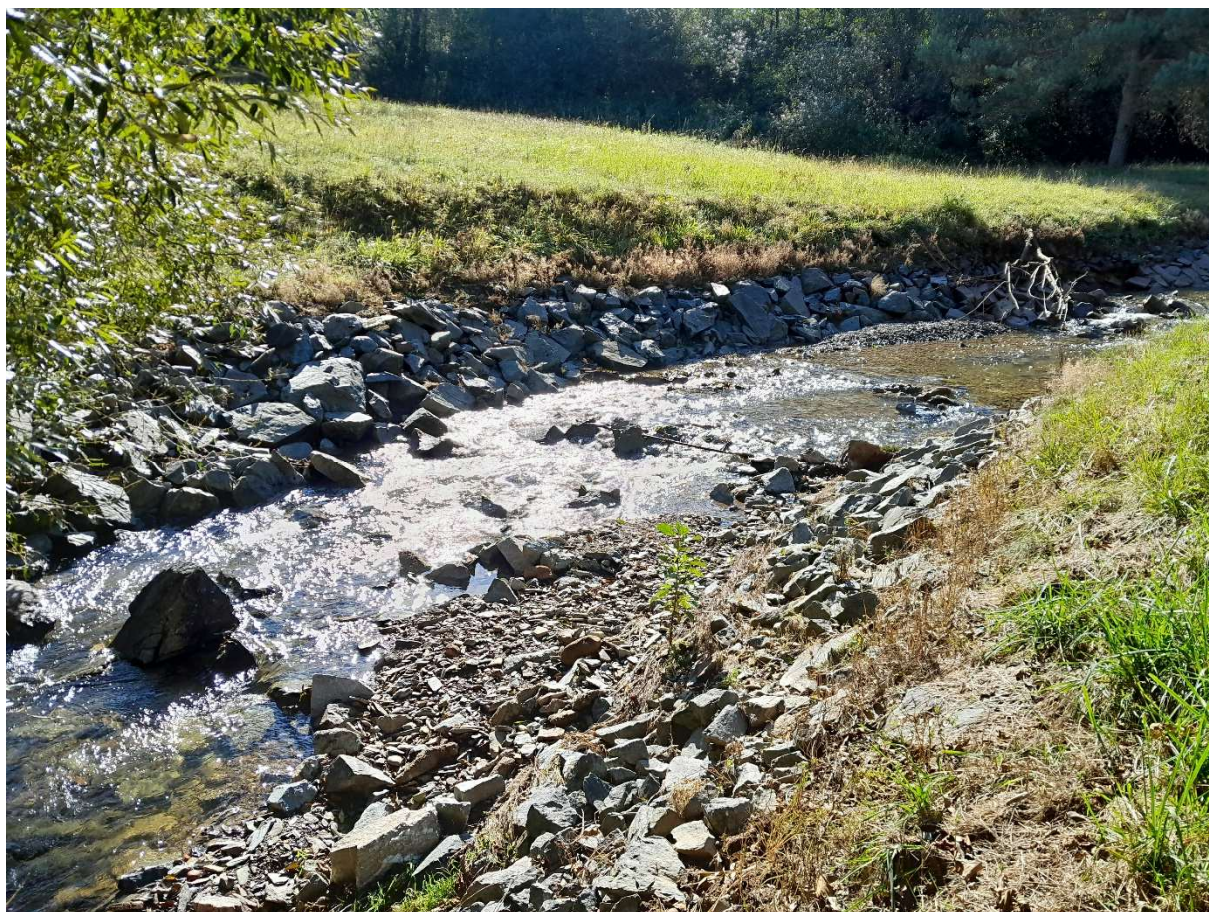
3. Štěrkové nánosy ve dně a porušené opevnění na levém břehu
